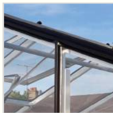
Fixation vitrage avec joint néoprène
