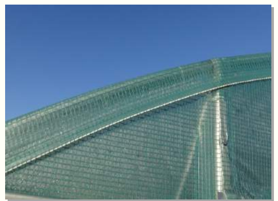
Tendeur et câble acier gainé serti sur bâche de couverture
