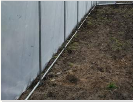
Entretoises diam 32 mm sur le pourtour de la serre
