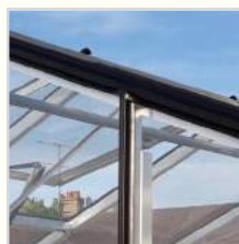
Fixation vitrage avec joint néoprène
